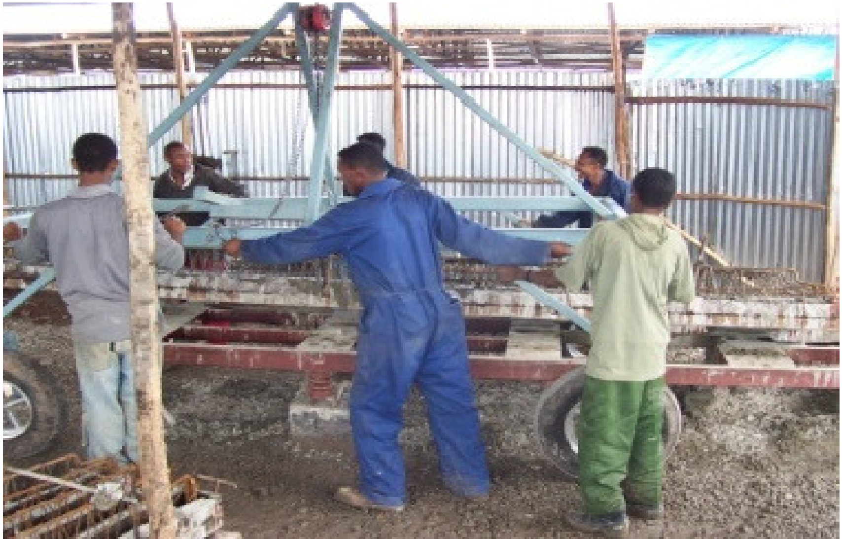
MSE on precast beams production
